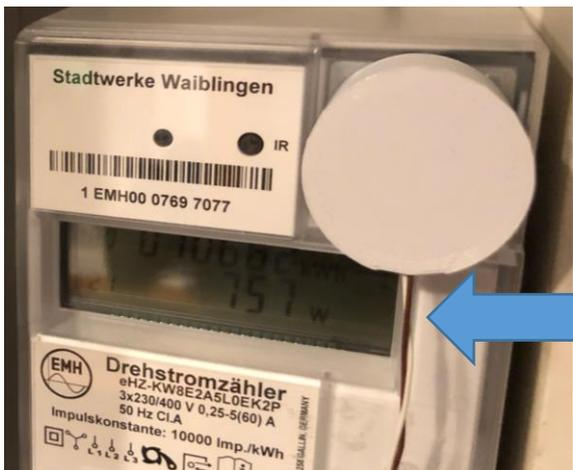
Das Kabel muss unten sein, damit der Fototransistor richtig ausgerichtet ist
